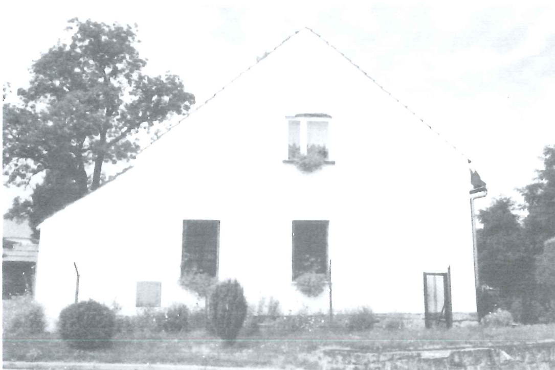
Fot 11. Budynek Caritas - widok od strony południowej. (stan na dzień 1.08.2019).
