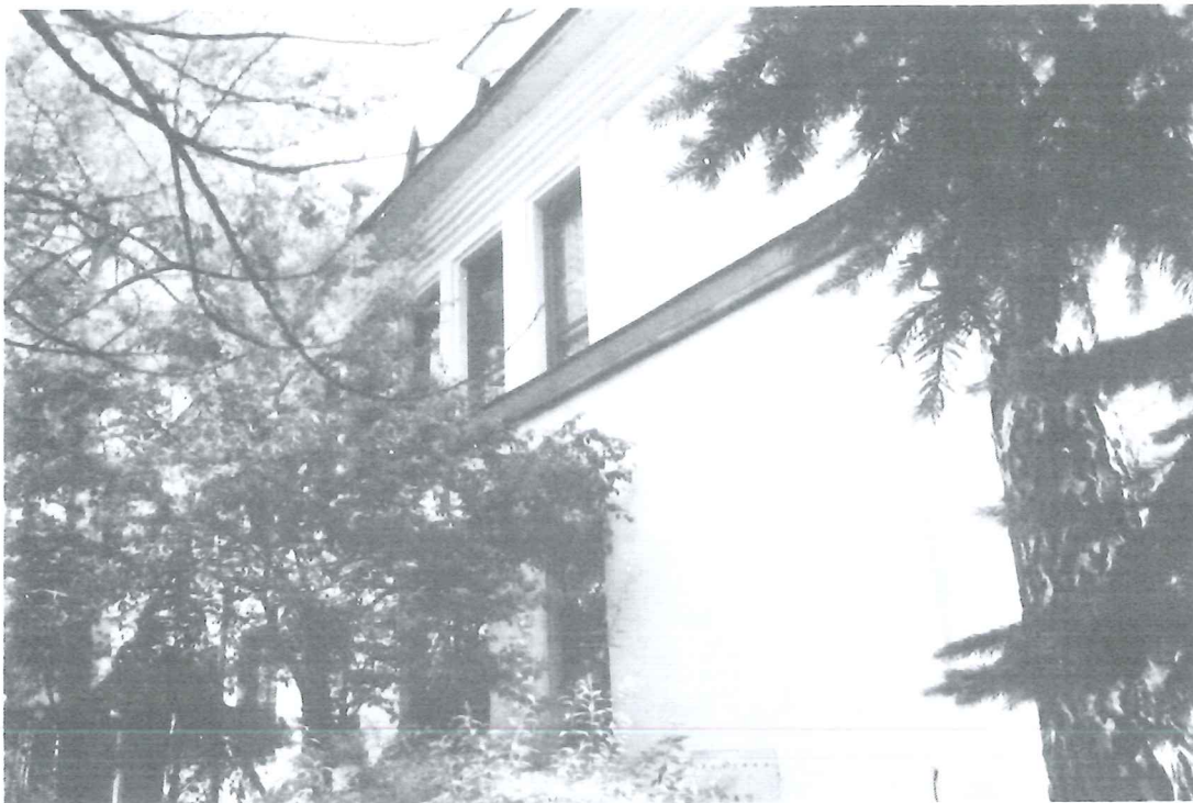
Fot 7. Ściana północna Domu Pielgrzyma. (stan na dzień 1.08.2019).
