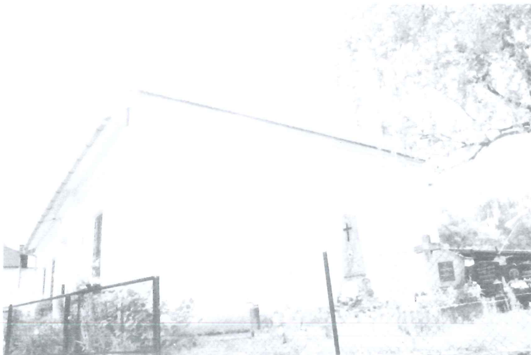
Fot 9. Ściana północna budynku Caritas. (stan na dzień 1.08.2019).
