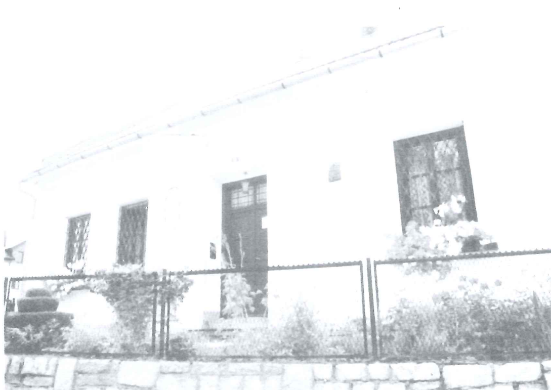
Fot 8. Budynek Caritas, widok od strony wschodniej. (stan na dzień 1.08.2019).
