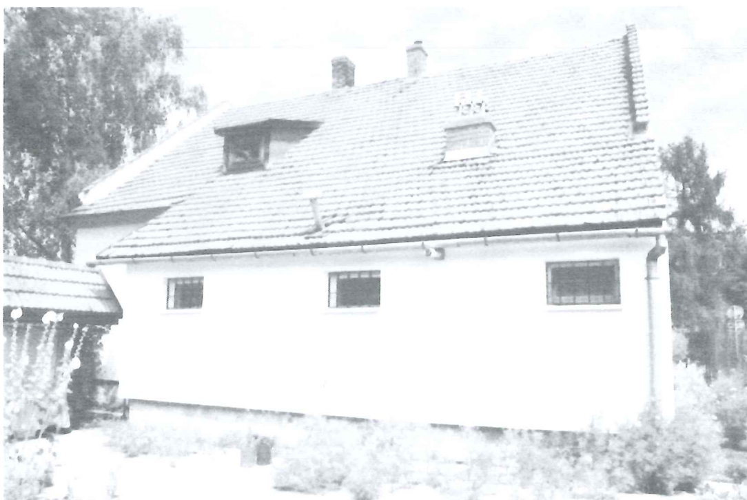
Fot 10. Ściana zachodnia budynku Caritas. (stan na dzień 1.08.2019).
