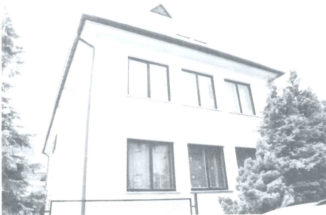
Fot 2. Dom Katechetyczny, ściana wschodnia. (stan na dzień 1.08.2019)
