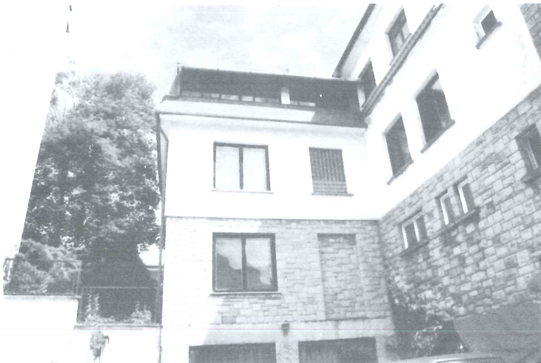
Fot 3. Ściana zachodnia Domu Katechetycznego, przylegająca do Plebanii. (stan na dzień 1.08.2019).
